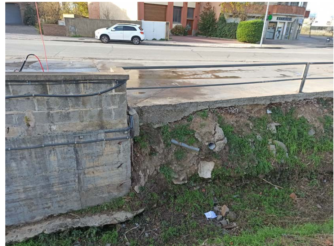
Imatge 3. Vista canvi de mur a talús inici àmbit de projecte i tub dn200 sortida embornal
