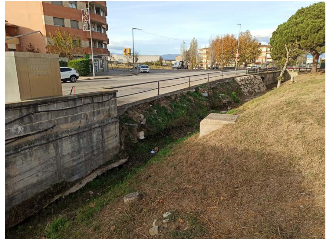
Imatge 3. Vista canvi de mur a talús inici àmbit de projecte i tub dn200 sortida embornal
