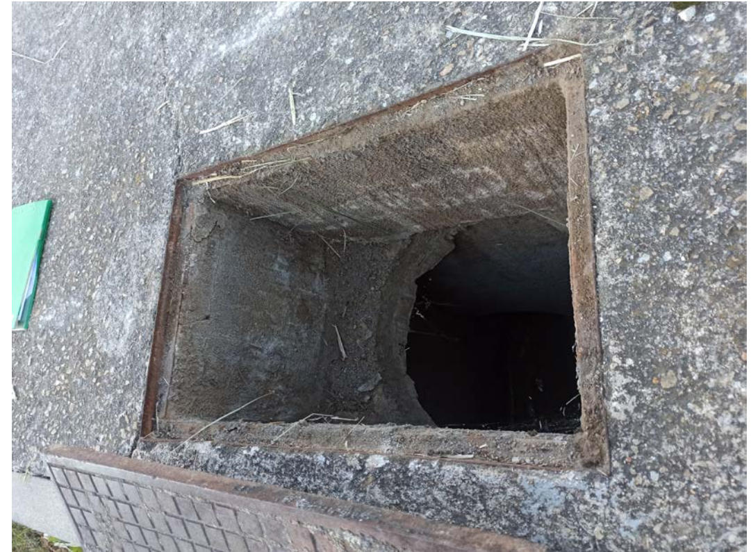
Imatge 11. Vista pou de registre (cambra sobreexidor) ubicat vorera abans pas de vianants carrer Miquel Martí i Pol. Tub dn600 aigua residuals i separació amb tub dn600 sobreexidor cap a al torrent del Pas
