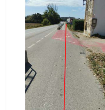
MR per carril bici a 20 cm de la línia de fresat cap endins.
