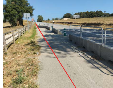
MR per carril bici a 20 cm de la línia de fresat cap endins per futures modificacions de calçada. Es poden treure les barreres de formigó per poder executar la MR. Aquestes barreres de formigó estan de manera provisional demanades per Vies Verdes per delimitar aquest espai del carril bici.
