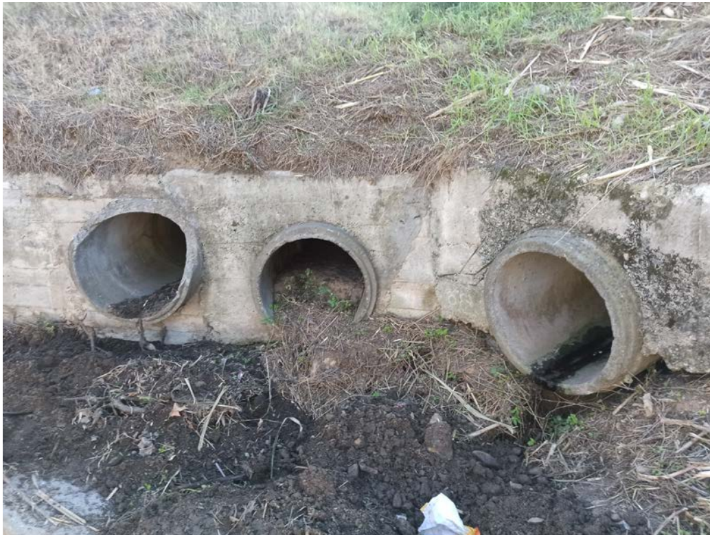
Imatge 13. Vista detall sobreexidors (3 tubs dn600 formigó)
