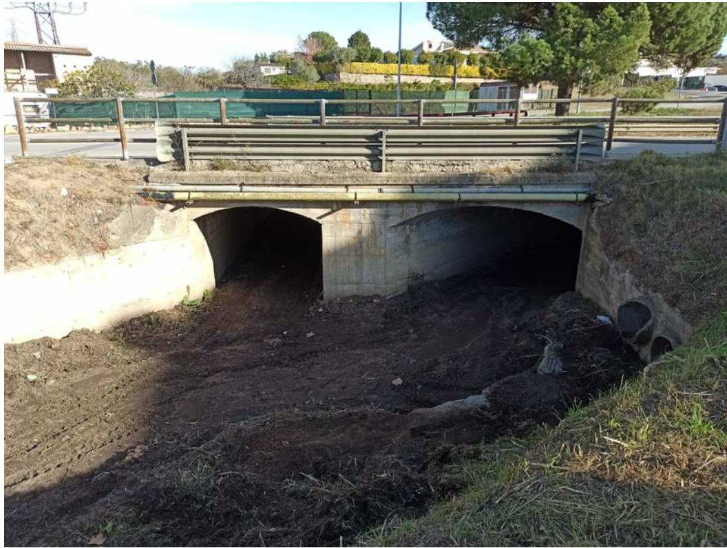
Imatge 13. Vista detall sobreexidors (3 tubs dn600 formigó)
