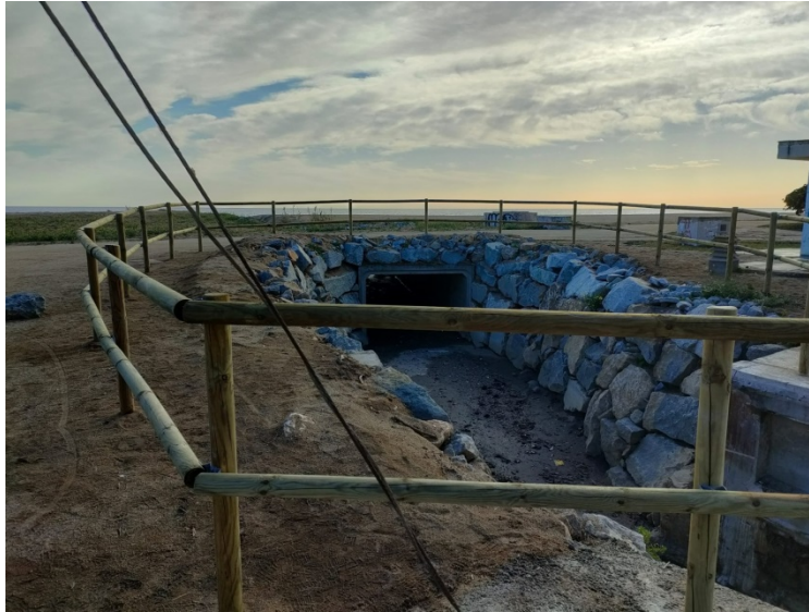
Imatge 21. Fotografia d'exemple d'aletes d'escullera a la sortida d'un calaix prefabricat
