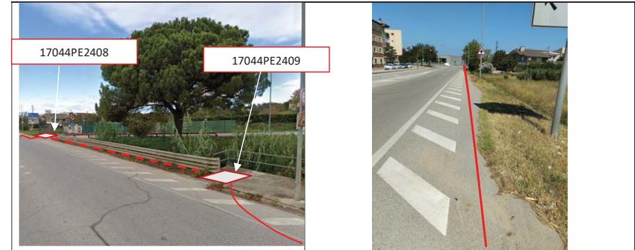
Nous registres B2 17044PE2408 i 17044PE2409. Pas de pont amb instal·lació de tub metàl·lic grapejat. Execució de la MR per fora de la línia de pintura per evitar la seva afectació.
