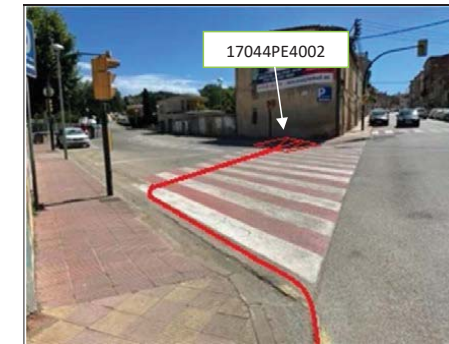
Sortida de la canalització des del pericó existent tipus C2 (17044PE4002) a la Ctra. de Palamós cruïlla amb el C/ del Castell amb tipologia ST-1 i ST-7
